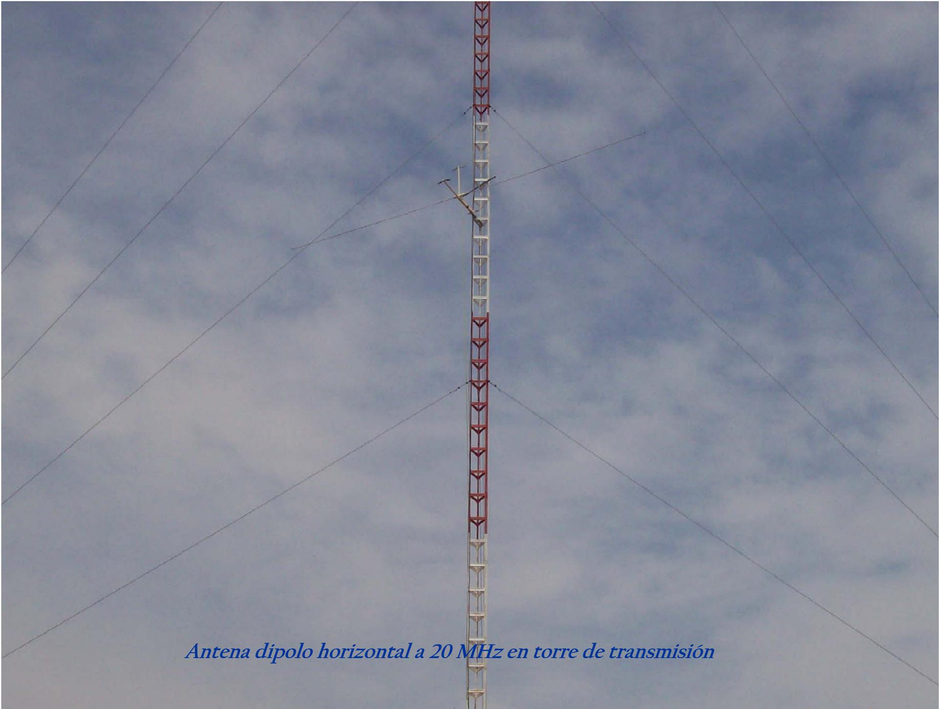
*Antena dipolo horizontal a 20 MHz en torre de transmisión*
