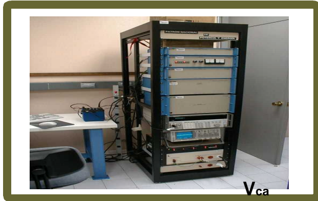
Patrón Nacional de Potencia y Energía Eléctrica
