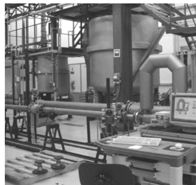
Figura 4. Instalación del medidor de flujo másico.
