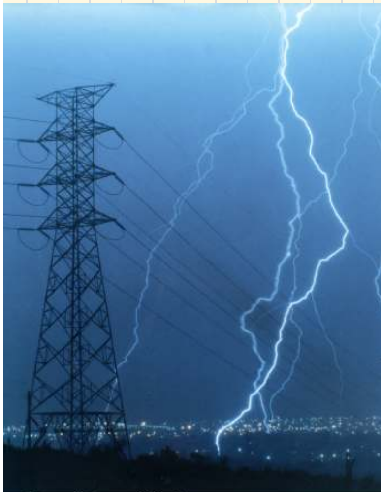
Líneas de Transmisión Monterrey Nuevo León, México
