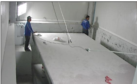
Fig. 2. Masa de concreto para medición absoluta de la aceleración de la gravedad.
