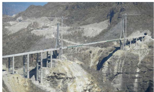
Figura 1. Puente El Baluarte
