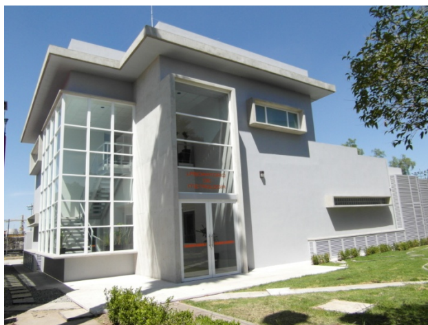
Fig. 1. Edificio del Laboratorio de Metrología del STC
