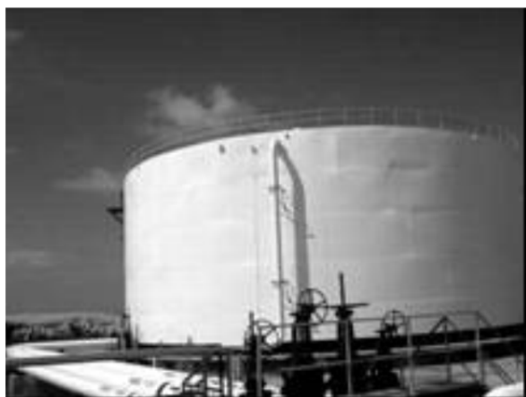
Fig. 1 Tanque de almacenamiento vertical
