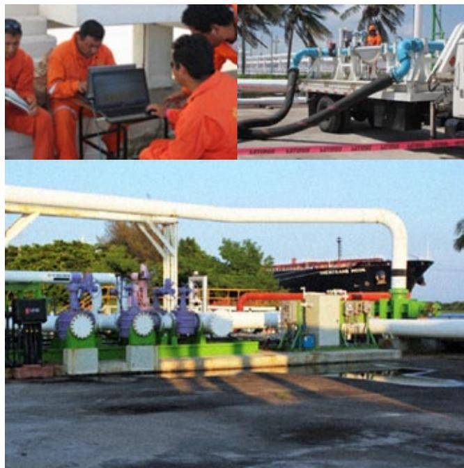
*Sistemas de medición, en el recuadro superior izquierdo el grupo de trabajo del CENAM; en el superior derecho el sistema M2, propiedad del CENAM, que se utilizó como sistema de referencia; y en el inferior la vista general del sistema de medición examinado*
