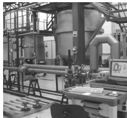
Figura 4. Instalación del medidor de flujo másico.
