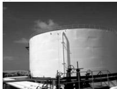
Fig. 1 Tanque de almacenamiento vertical
