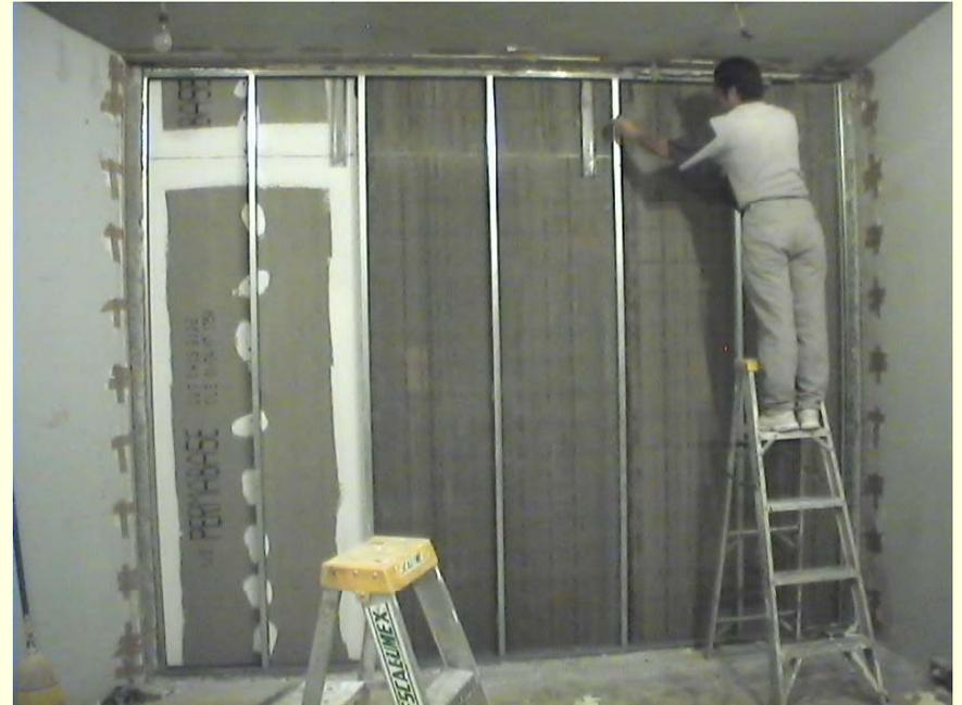
Estructura para montaje de los paneles de prueba
